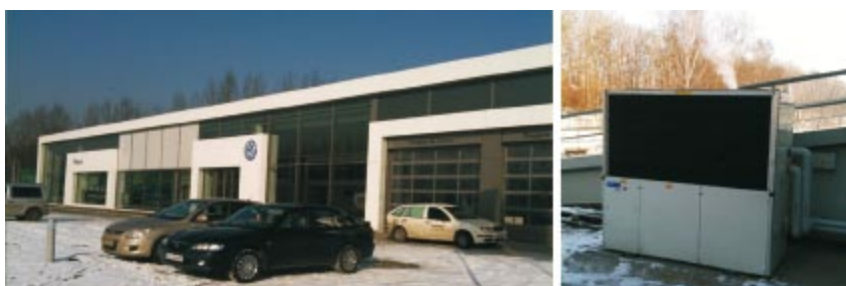
Rys. 13. Instalacja GHP AISIN w salonie samochodowym VW w Świętochłowicach. Układ GHP AWS, 71 kW
